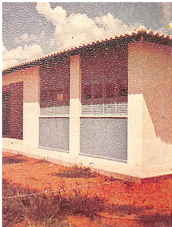
Um detalhe do prédio escolar
